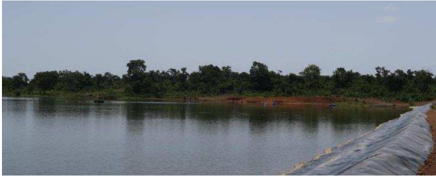
Figure 26 : Vue du terrain à partir du réservoir
