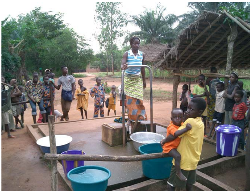
Forage équipé d'une pompe Vergnet HPV60-2000
