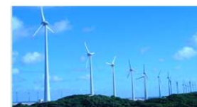
RN 15 - RIO DO FOGO 49,30 MW
