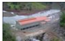
SÃO BERNARDO 15 MW
