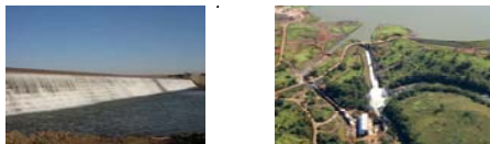
JATÁ 30,00 MW / IRARA 30,00 MW
